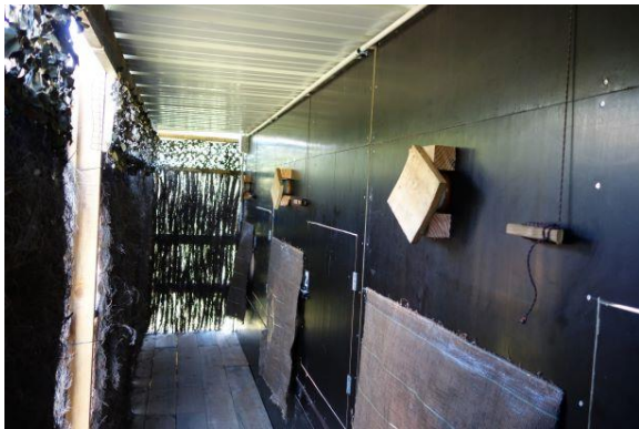
Photo 5: Sas de sécurité avec portes d'accès aux boxes
