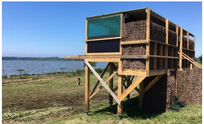
Photo 2 : Installation de la volière sur pieux vissés
