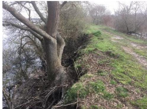
*Circuit de visite Digue sud du Marais Barrage – érosion importante (jusqu'à 1,50m) par effet des vagues dans le casier*
