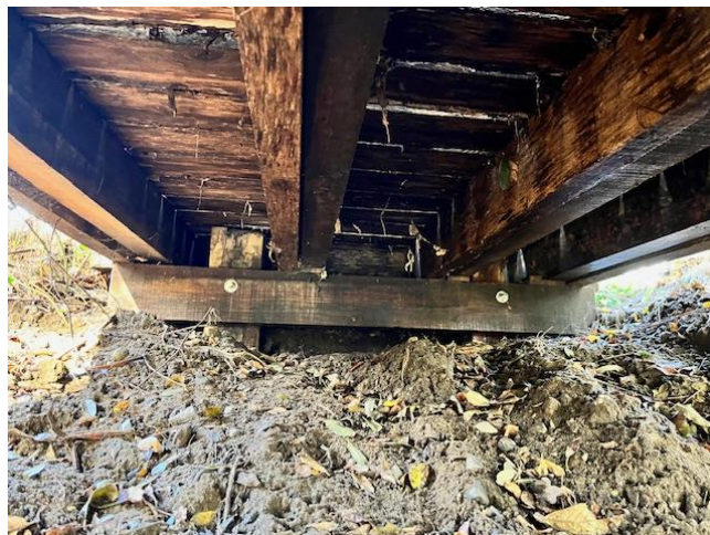
Renforcement de l'entrée du circuit de visite – Marais pédagogique
