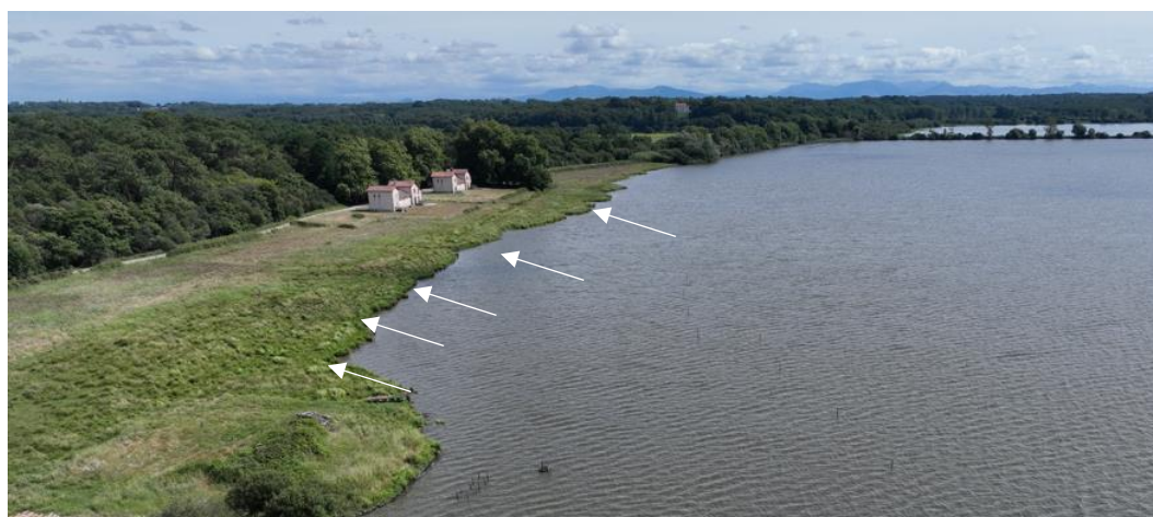
Zone d'érosion de la berge Est du Marais Central
