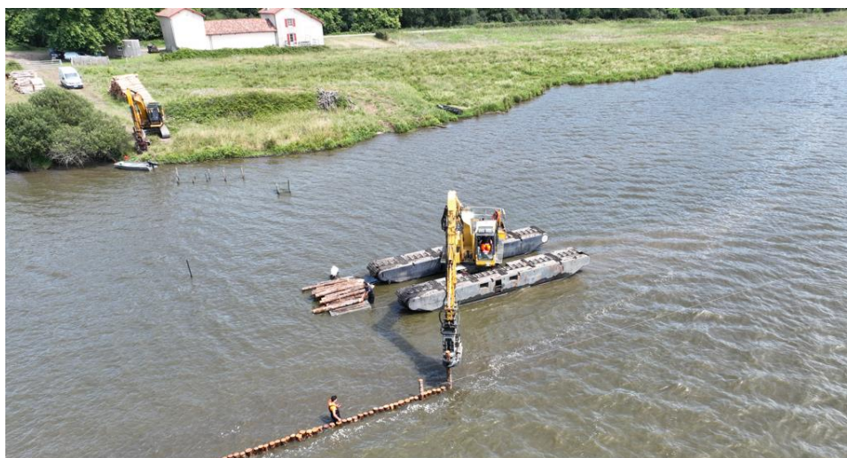
Pieutage d'un brise-vague à la pelle amphibie
