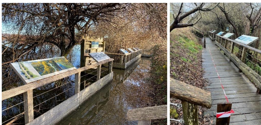
Galleries des artistes sécurisée suite aux inondations
