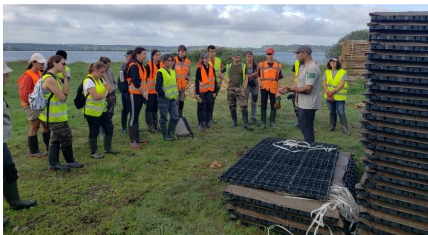
Chantier pédagogique avec le Lycée Jean Errecart
